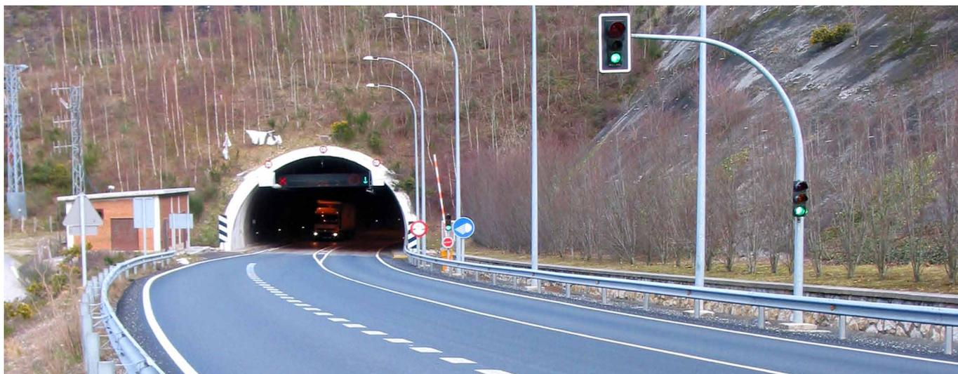
En ambos túneles se debe de realizar una inspección de la bóveda, adoptando las medidas preventivas necesarias, y realizar la adecuación de las instalaciones para el cambio del sentido a unidireccional. Además, se ha estimado la necesidad de cambio del cableado existente a uno tipo afumex
