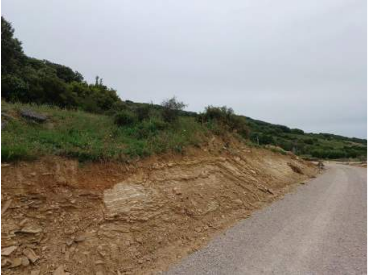
Punto PR05. Punto cercano a edificación
