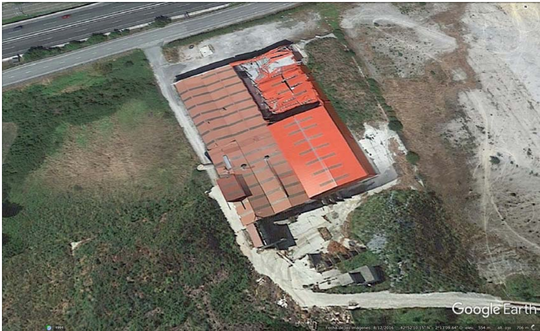
Vista aérea de las instalaciones de Aralur, con los lodos contaminantes acopiados
