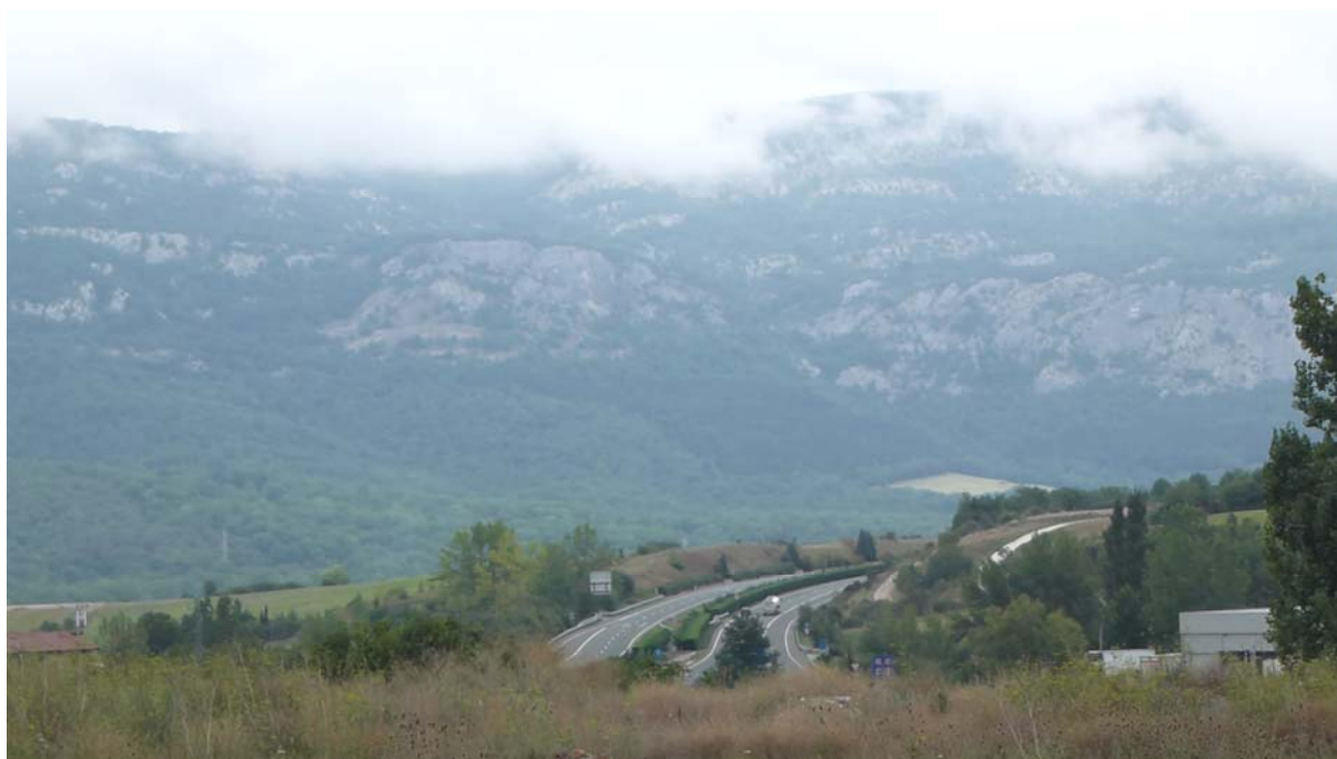
Vista de la Autovia A-10 desde el punto más cercano de la parcela 391.
