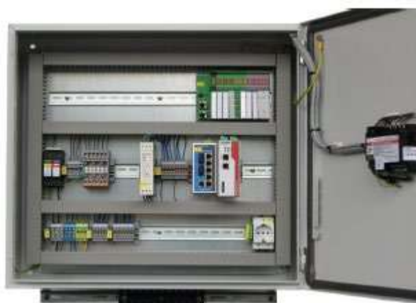
Ilustración 3. Armario del Controlador de Planta (PPC).
