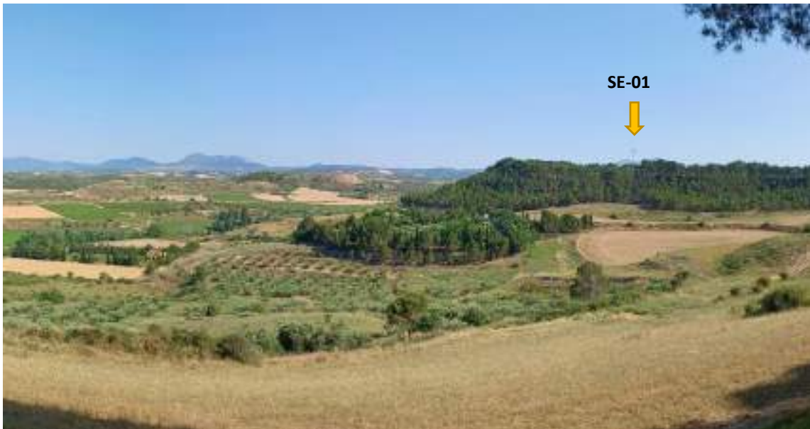
CON INFRAESTRUCTURAS INSTALADAS
