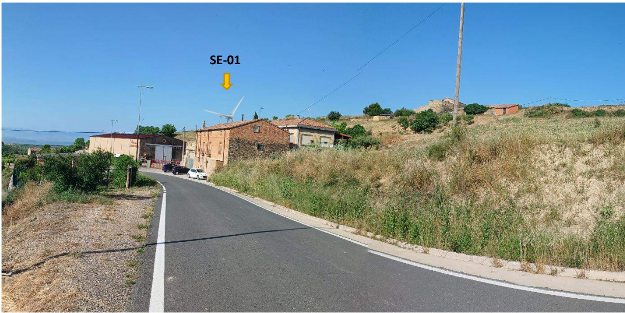
CON INFRAESTRUCTURAS INSTALADAS
