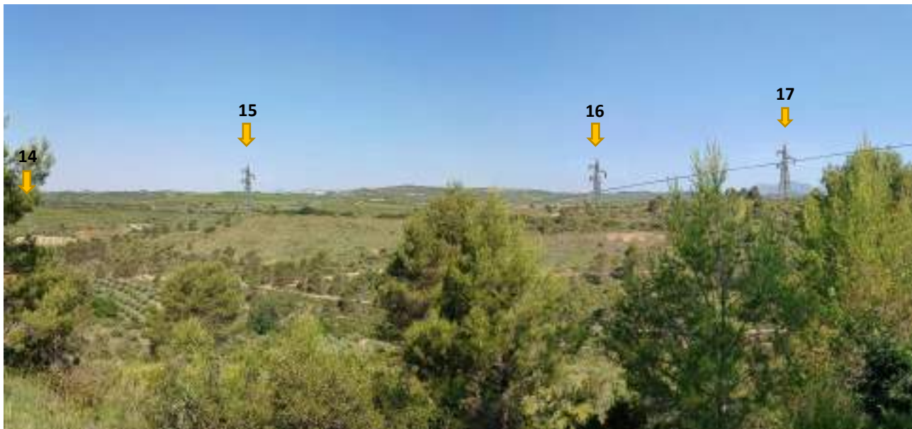
CON INFRAESTRUCTURAS INSTALADAS
