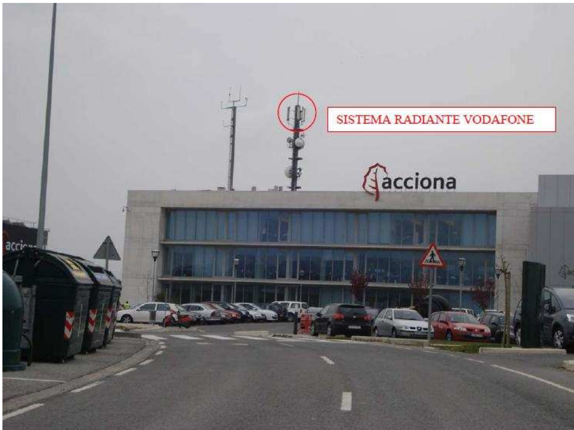
Figura 3: Instalación existente de VODAFONE.
