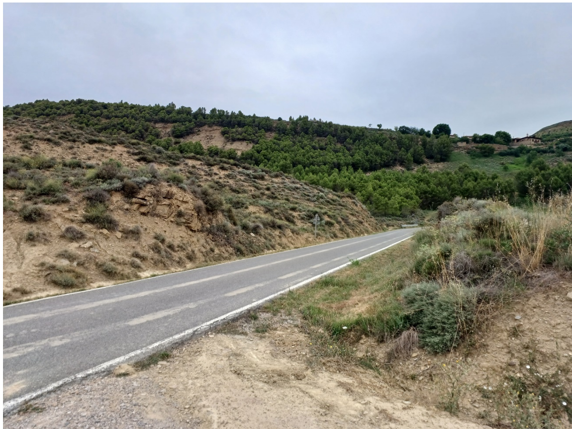
Ilustración 2. Vial de acceso al proyecto contiguo a la zanja próximo al este de la PSFV.
