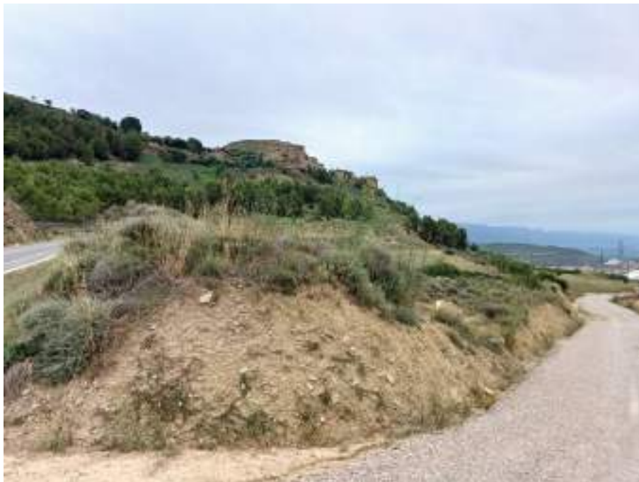
Fotografía 3. Zona de matorral mediterráneo, coincidente con la zanja de evacuación.
