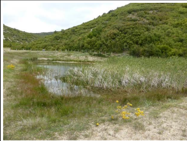
Balsa de PVC en Berroya. En este caso se está produciendo una naturalización de la infraestructura
