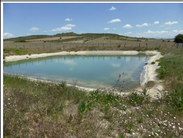
Balsa de EPDM sin orla de vegetación en San Esteban de Ugarra
