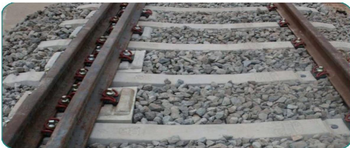
La instalación de este tercer carril puede realizarse sobre una vía ya existente o sobre una nueva vía a construir.
