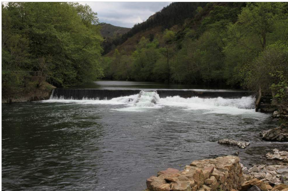
Figura 8-18. Imagen de la presa de la central hidroeléctrica de Endarlatsa con escalas de peces (centro y derecha).
