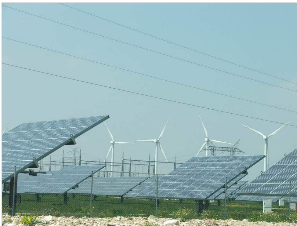
Figura 8-22. Vista de un huerto solar de Navarra con un parque eólico en el fondo. Fuente: GAN-NIK
