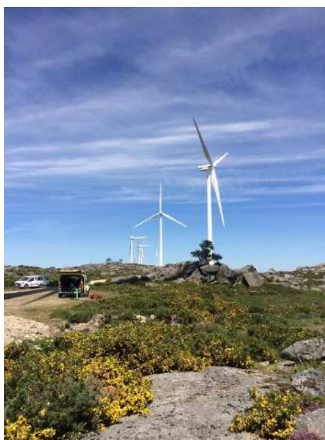
Figura 9-2. Imagen de trabajos de inspección y mantenimiento en un parque eólico. Fuente: Imagen cedida por Eolive Vertical.
