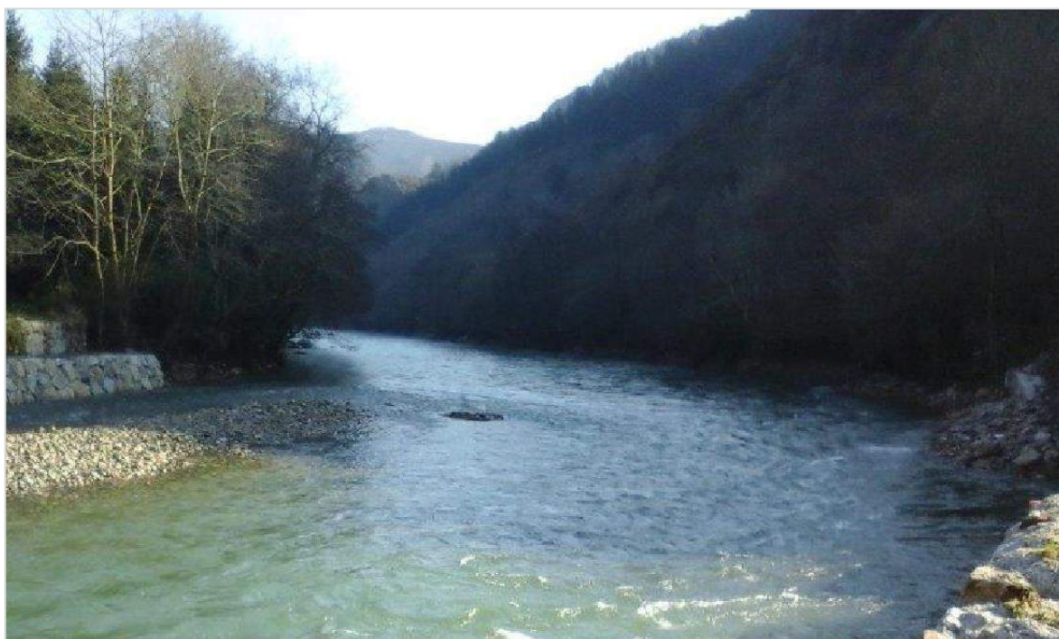
Figura 8-19. Imagen tras la eliminación de la antigua presa de la central hidroeléctrica de Endarlatsa promovido por el proyecto Life Irekibai. Fuente: GAN-NIK
