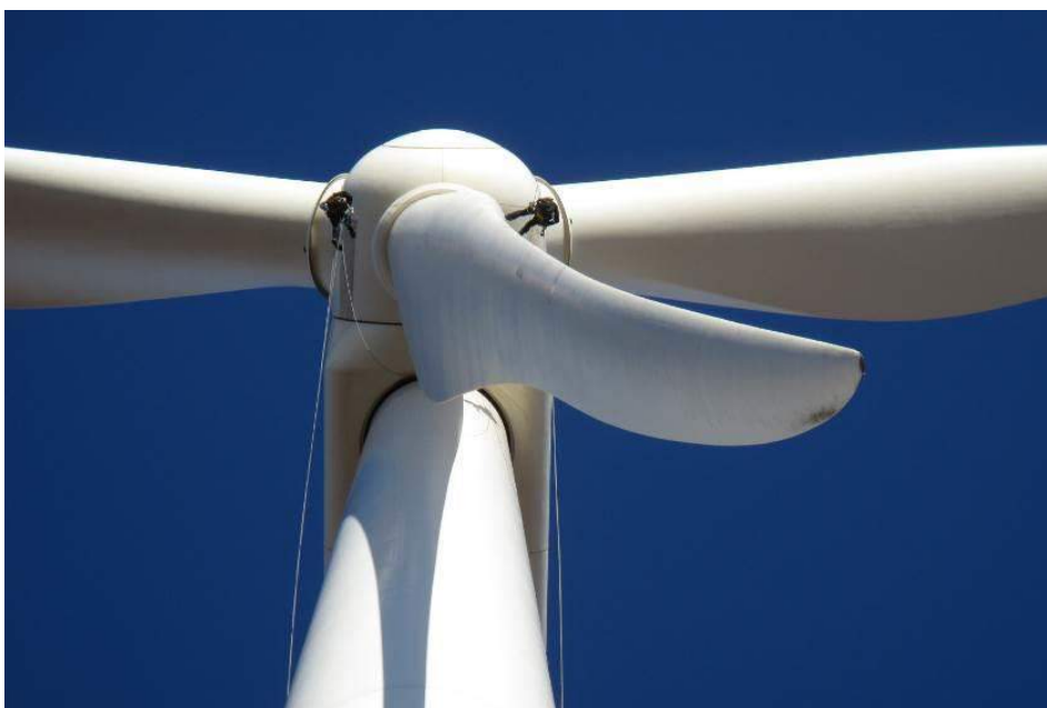
Figura 8-1. Imagen de trabajos de mantenimiento en un parque eólico. Fuente: Imagen cedida por Eolive Vertical.
