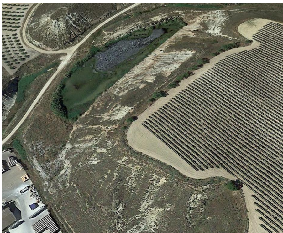
Balsa junto a las naves industriales
