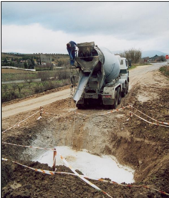
Punto de limpieza de cubas de hormigón
