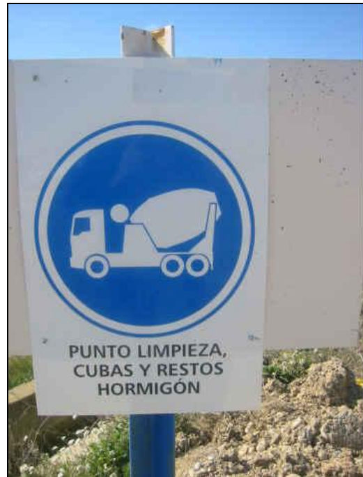
Punto de limpieza de cubas de hormigón
