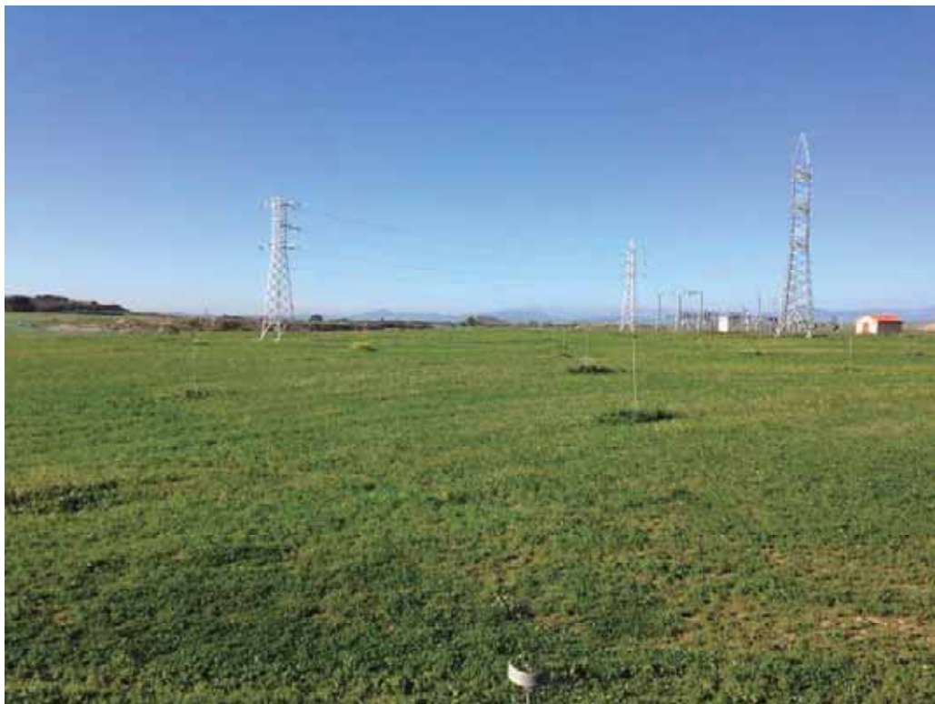
Fotografía 8: Vista general desde paso elevado autovía A68. Destacan campos de cultivo e infraestructuras eléctricas.
