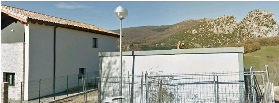
IRURTZUN, muy cerca del cementerio: En un punto alto situado al noreste del núcleo urbano. Vista hacia el norte, hacia la ladera por la que discurriría la Alternativa 2.
