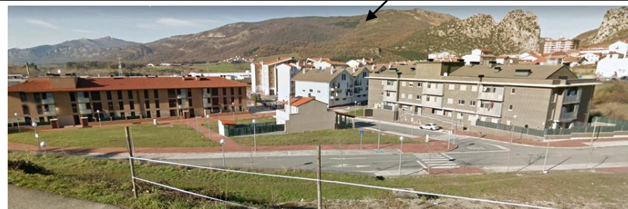
IRURTZUN, en el acceso a las piscinas: En un punto alto situado al sur-sureste del núcleo urbano. Vista hacia el noroeste-norte. La flecha señala un punto por donde la antena pasaría.
