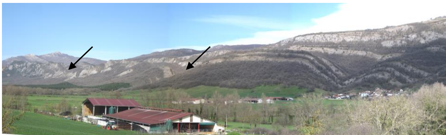
ETXARREN: Vista hacia el noroeste. Al fondo, a la derecha, se puede ver Egiarreta. A su izquierda está la ladera por la que ascendería la Alternativa 1 . También se vería el roquedo vertical de la Alternativa 3 .
