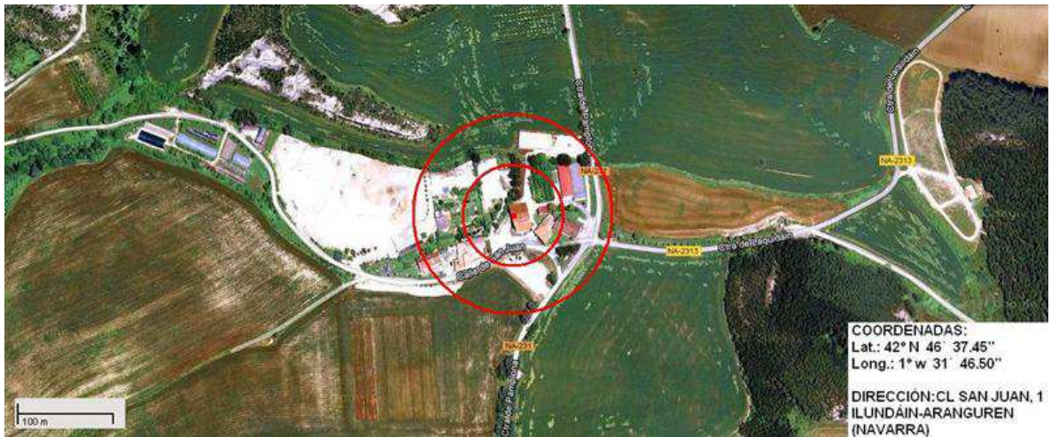
Figura 1. Ortofoto de ubicación de la estación base denominada ILUNDAIN EB.
