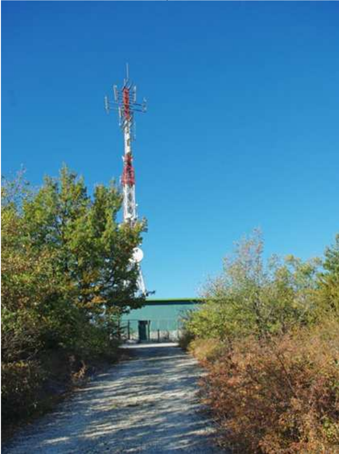
Instalaciones: Aspecto de la antena
