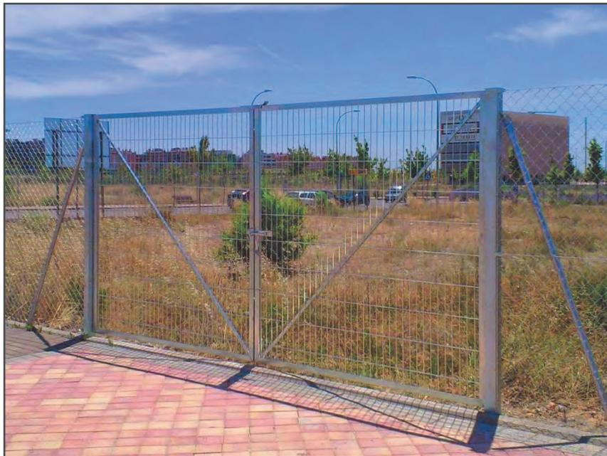
*Ejemplo de puerta metálica de doble hoja que completa el cierre perimetral a modo de valla metálica de simple torsión.*
