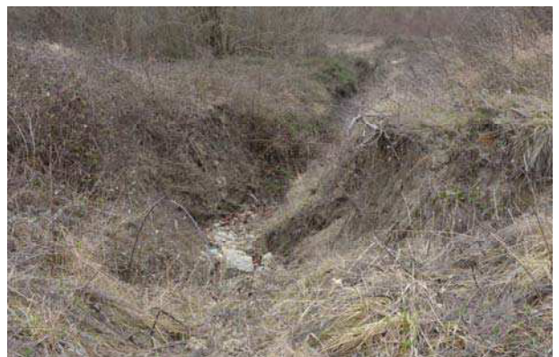
Cuneta de guarda sector oriental
