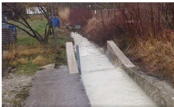
Vertido a regata Troskera y equipo de medida de caudal.
