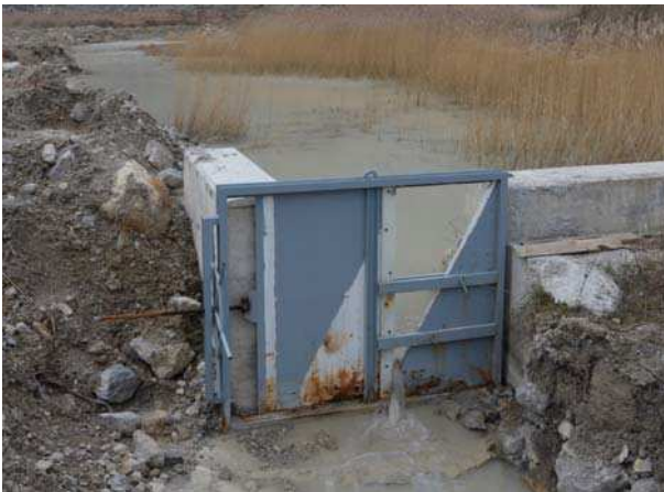
Obra de salida de aguas de la plaza de la cantera
