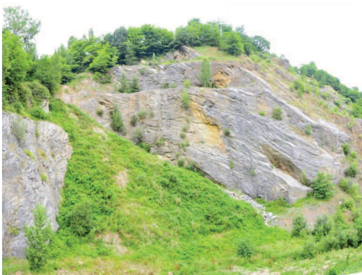
Imagen 15: Detalle del cono de materiales aportados hace años entre los taludes Oeste y Noroeste
