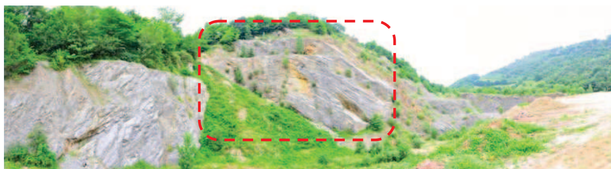
Imagen 7: Situación del talud Noroeste en el frente de explotación
