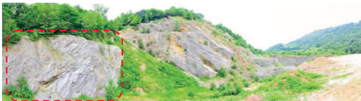
Imagen 5: Situación del talud Oeste en el frente de explotación
