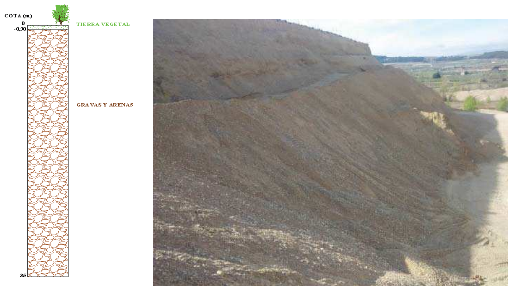
Ilustración 3: Corte geológico y vista de la existencia del recurso en la explotación.
