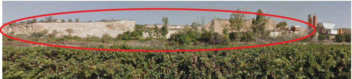
Ilustración 62: Terraza en explotación, tanto en la gravera "VICUÑA-I", como en la vecina gravera "MUGA DE CARCAR", de la cual se distingue a la derecha la planta de tratamiento y hormigón.
