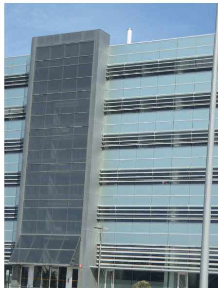
Figura 4: Antena de Telefónica mimetizada (después).
