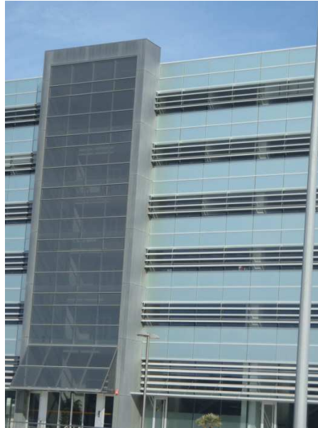
Figura 3: Edificio La Estrella (antes)
