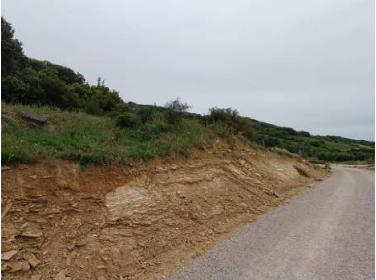
Punto PR05. Punto cercano a edificación
